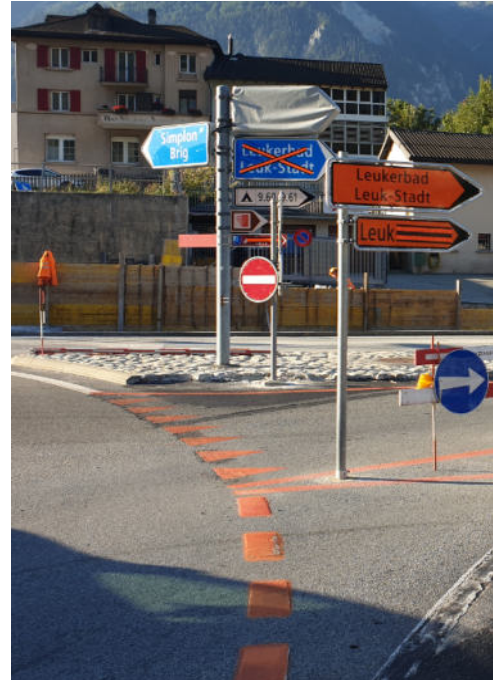
Signalisation de chantier
