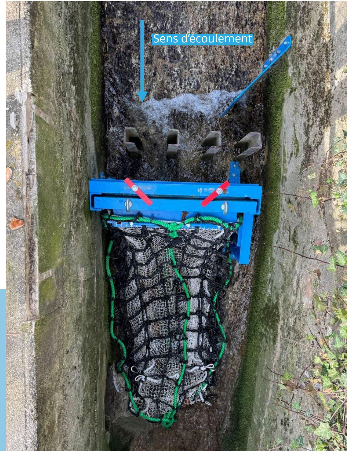
Rétention d' encombrants afin de prévenir l'introduction de matières et le colmatage du réseau d'eau enterré situé en aval - Lonay, Vaud
