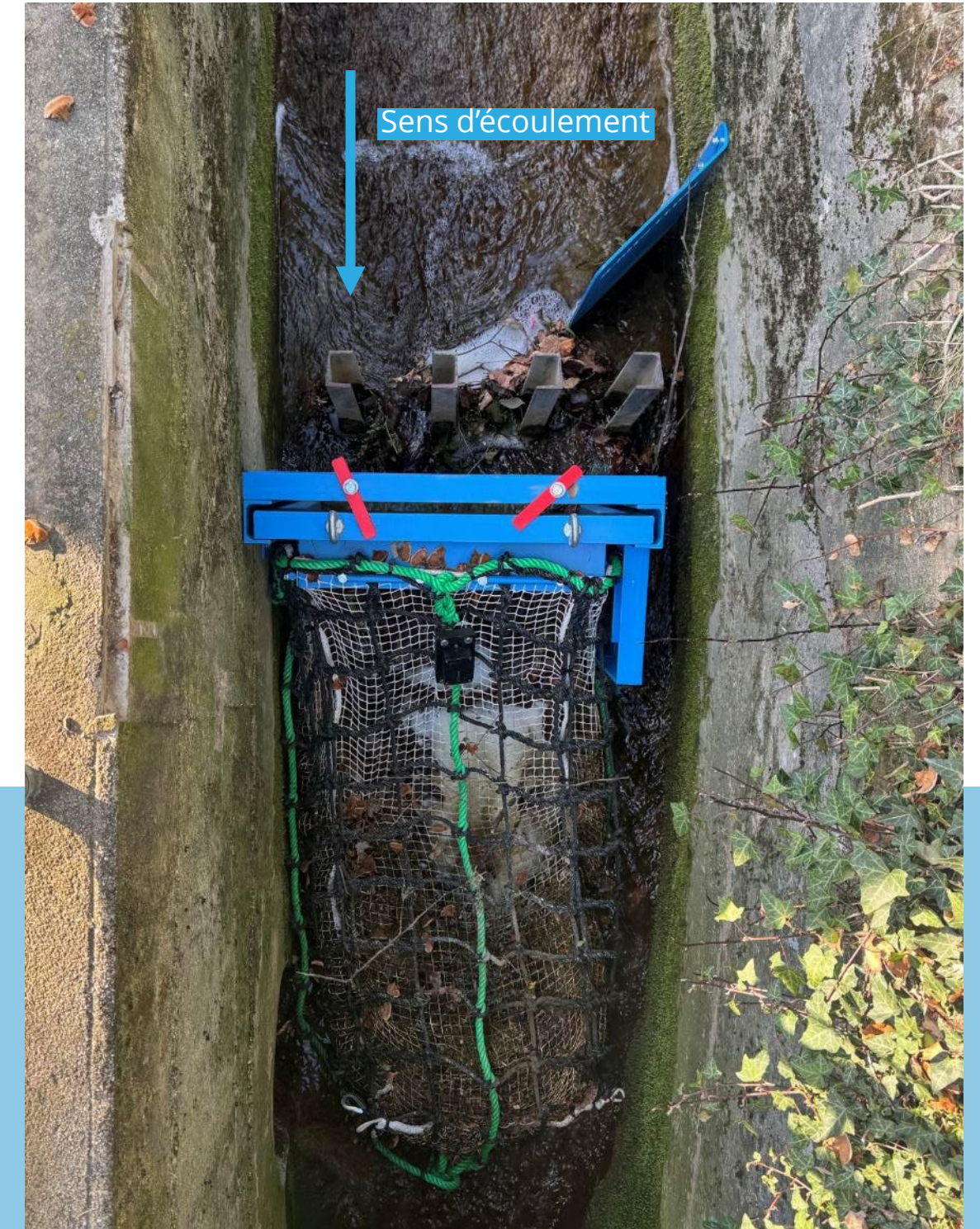
Rétention d' encombrants afin de prévenir l'introduction de matières et le colmatage du réseau d'eau enterré situé en aval - Lonay, Vaud
